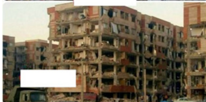
✚ تخریب واحد ۵ طبقه (ساختمان غیر از مسکن مهر) در جوانرود (عکس بالا) و خسارت بسیار کمتر واحدهای مسکن مهر سرپل ذهاب (عکس پایین)
